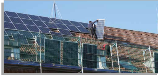
Installation der Fotovoltaikanlage auf Gebäude 1 im Dezember 2013
